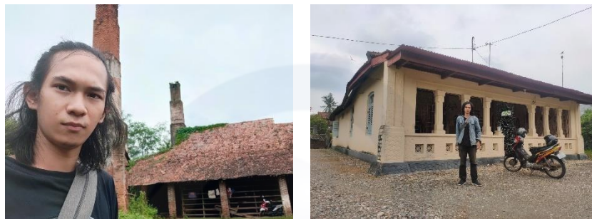
Gambar 1.3. Foto pabrik Agung Pratama, AB Sokka (kiri). Rumah kediaman Aboengamar (kanan). Dokumentasi pribadi.
